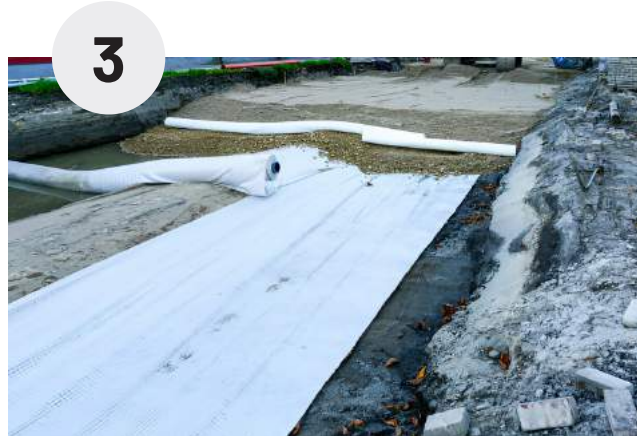
Trải lớp vinyl | Laying vinyl layer
