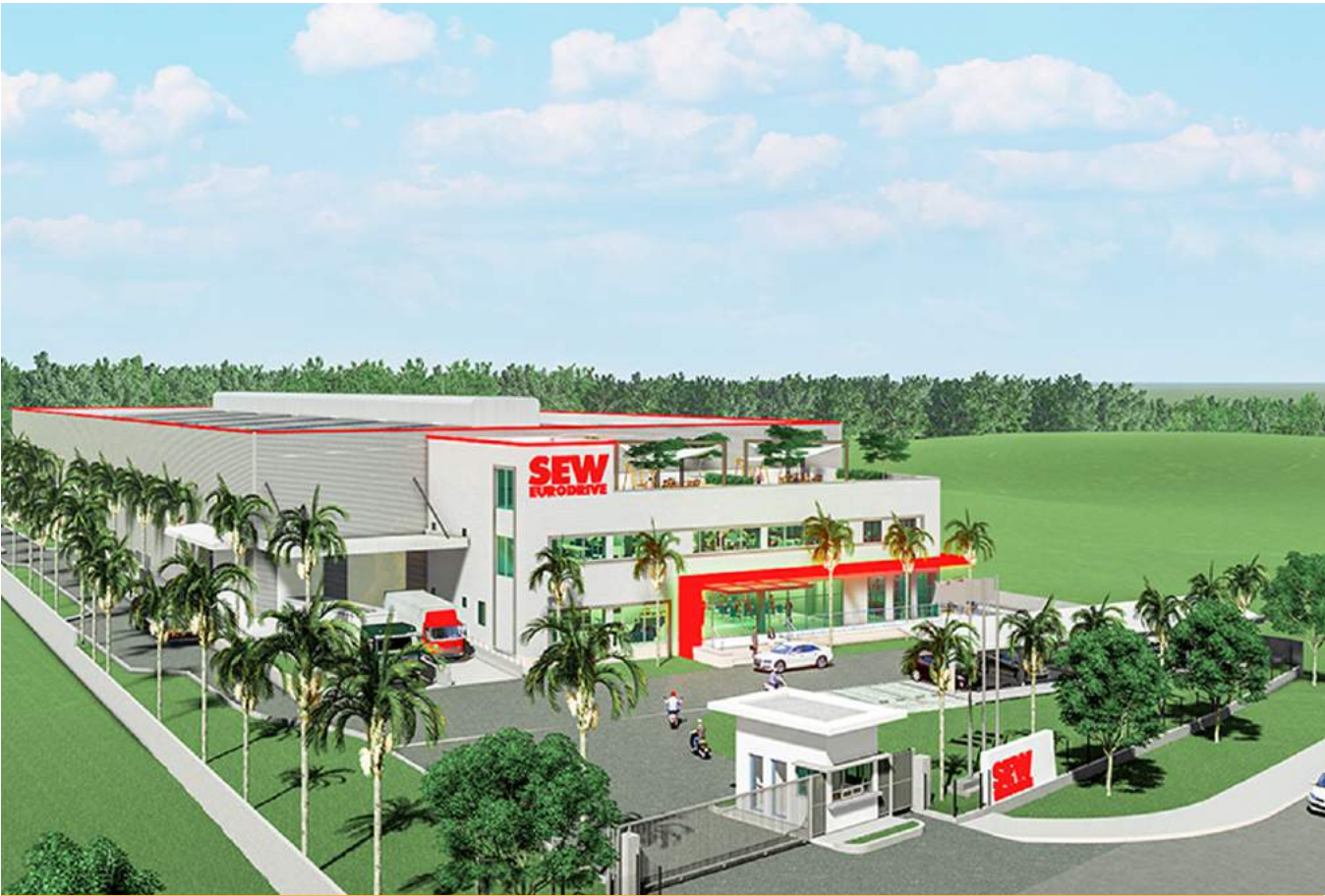
NHÀ MÁY LẮP RÁP SEW SEW ASSEMBLY FACTORY
