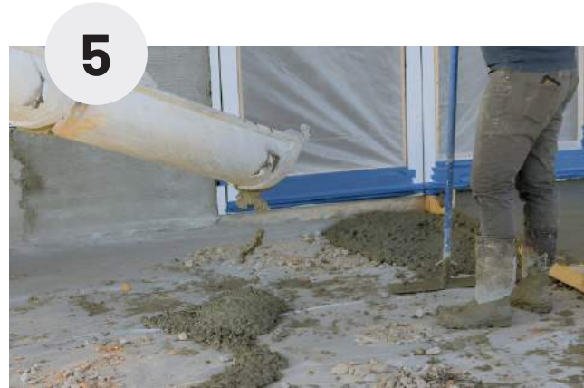
Đổ bê tông | Pouring concrete
