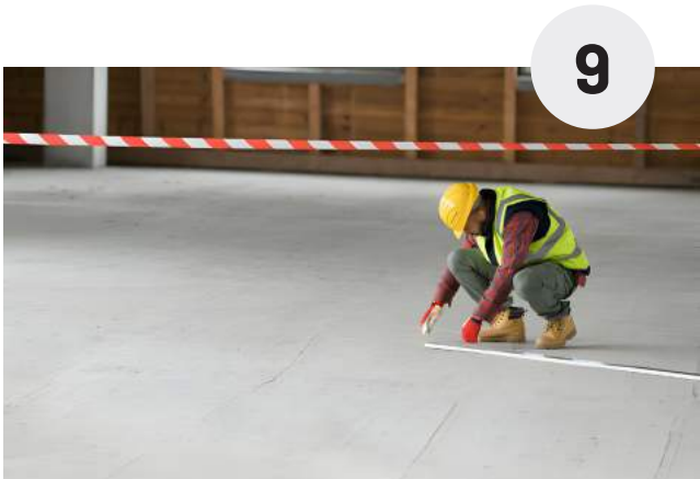
Hoàn thiện | Finishing
