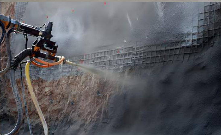
Bê tông phun Shotcrete
