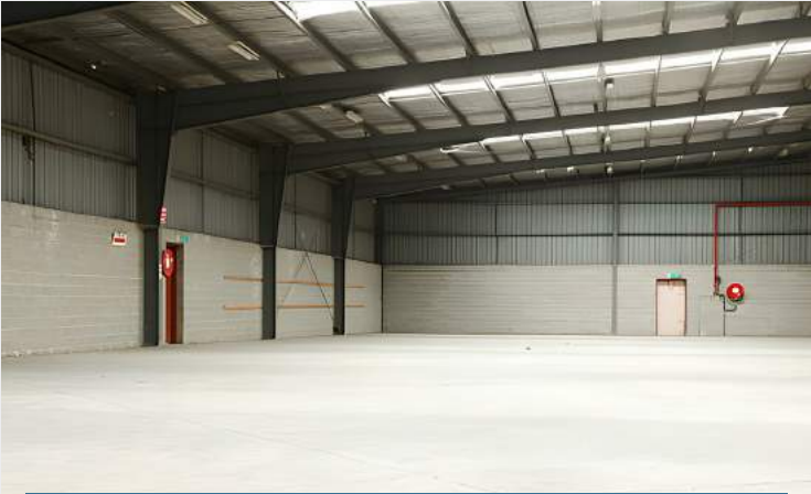
Nhà xưởng/ Nhà kho Factory/Warehouse
