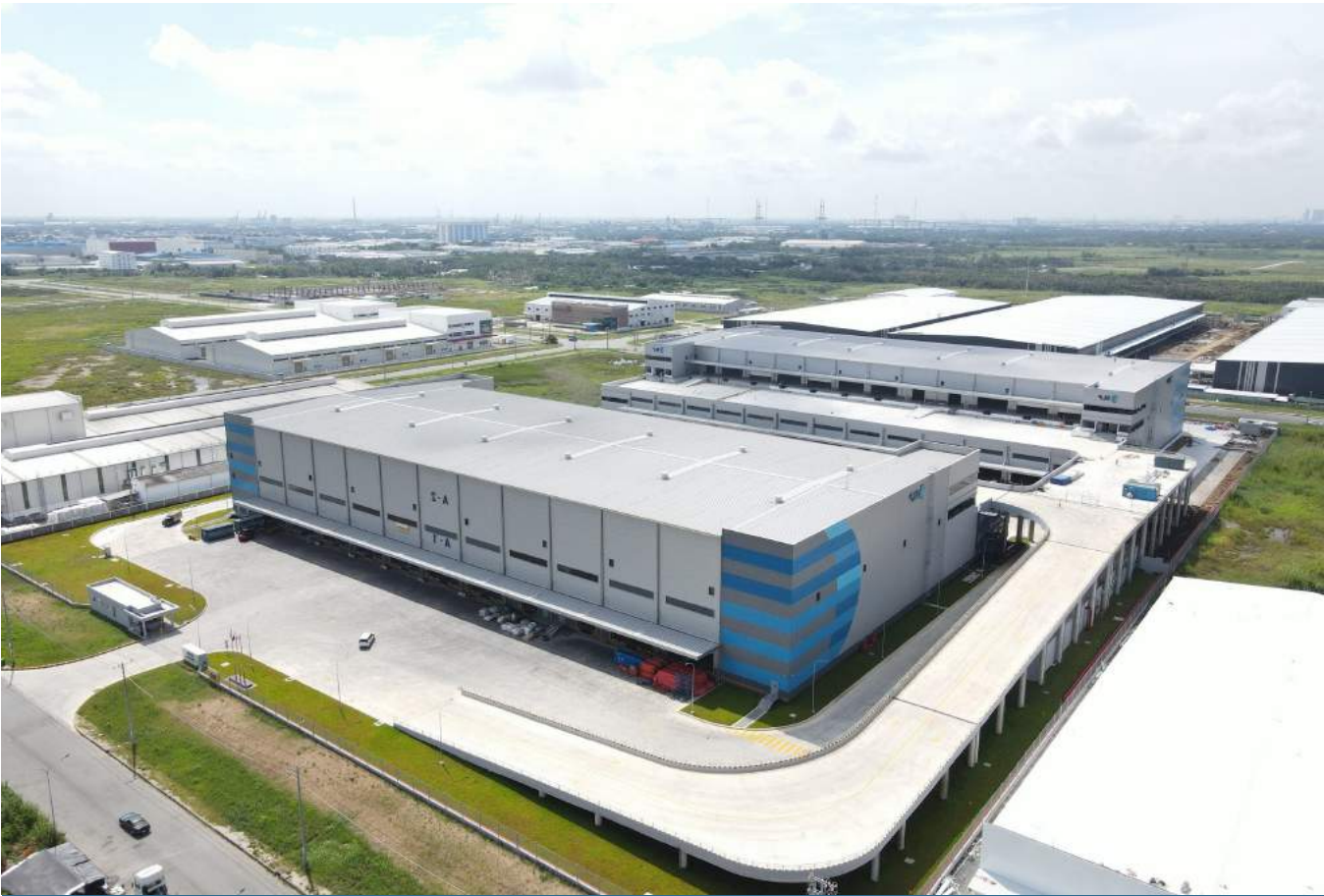
NHÀ XƯỞNG CHO THUÊ SLP LONG HẬU SLP LONG HAU INDUSTRIAL WAREHOUSE FOR LEASE
